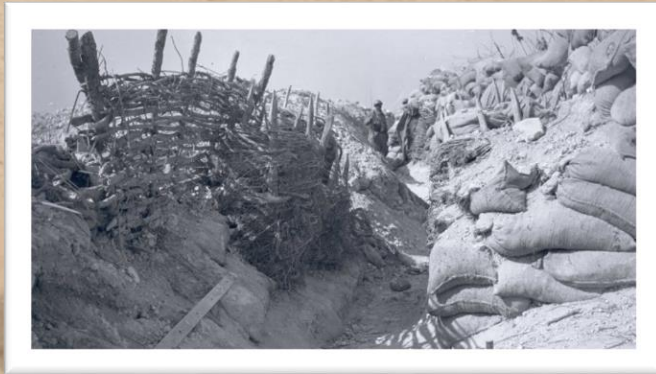
Écroulement des tranchées
