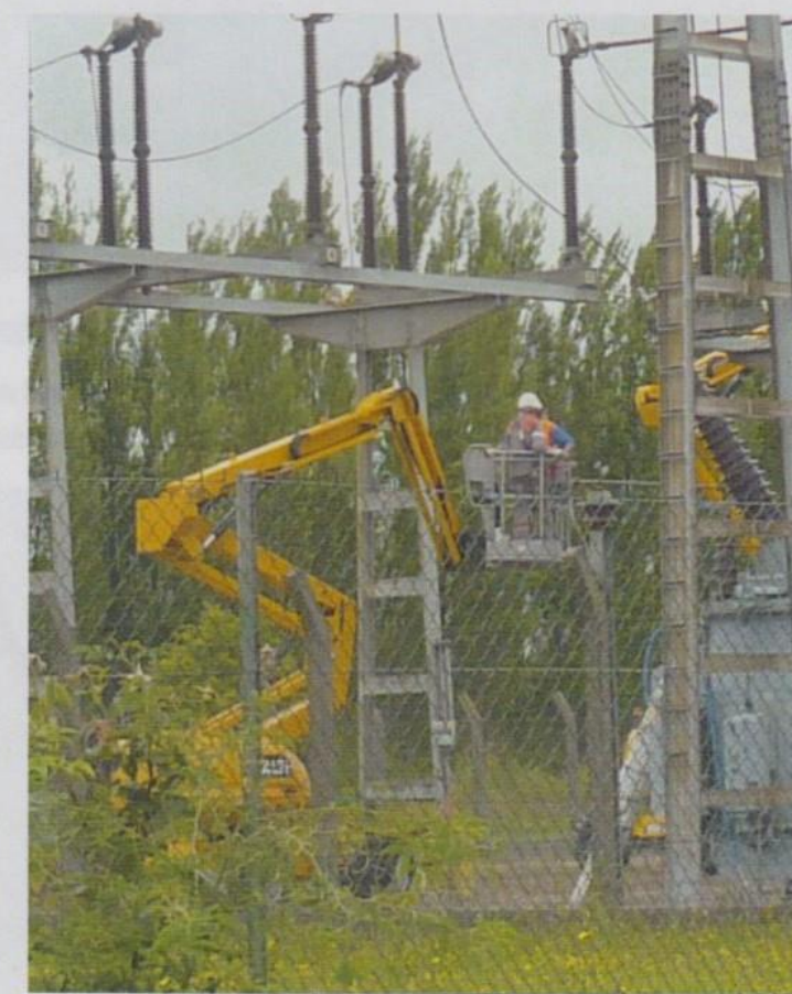
▲ Les travaux extérieurs n'ont pas été oubliés.
