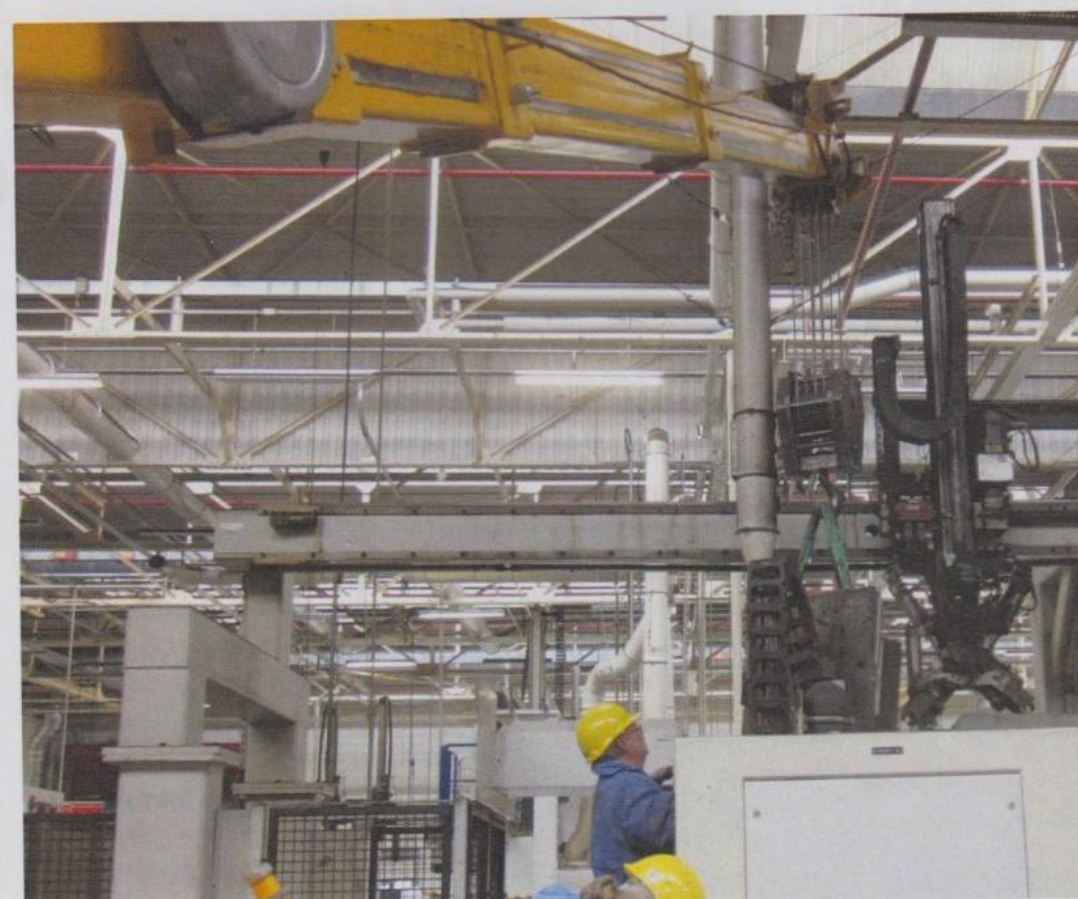
▲ Au bâtiment 8, remise en état dans la ligne des carters cylindres OP 80.
