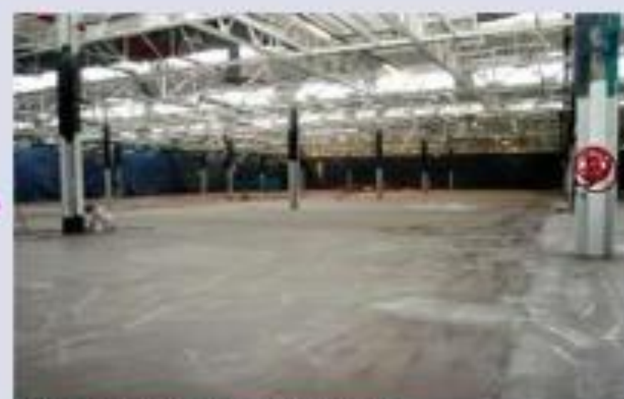
2011 : travaux de réalisation de la dalle Au total, 11 000 m 2 seront recouverts d'un nouveau béton.
