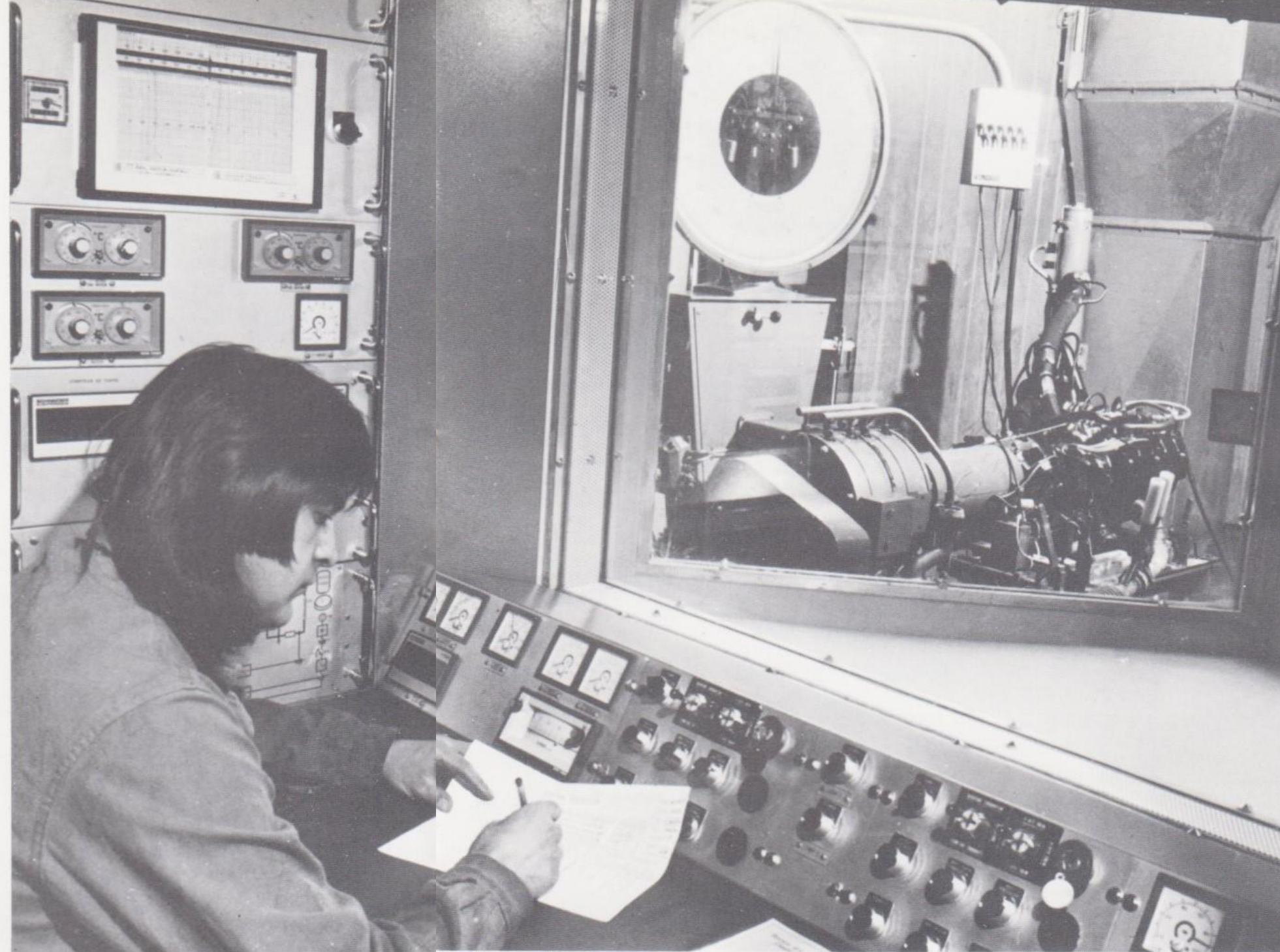
Huit bancs d'essais tournent 14 heures par jour pour détecter, soit les anomalies qui se manifestent de suite, soit celles qui surviennent à plus longue échéance. M. Guy Oger est en train de procéder ici au réglage de la puissance d'un moteur.
