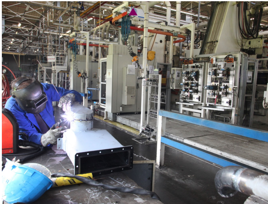
▲ Au bâtiment 5, un chantier travaux congés s'est tenu dans les carters DV à l'OP 800 pour la modification des goulottes.
