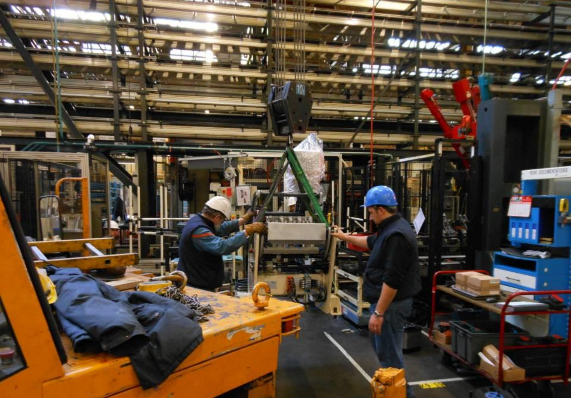
Ligne culasses flexible 3 : Mise en place du poste semi-auto pour les soupapes et les ressorts K9
