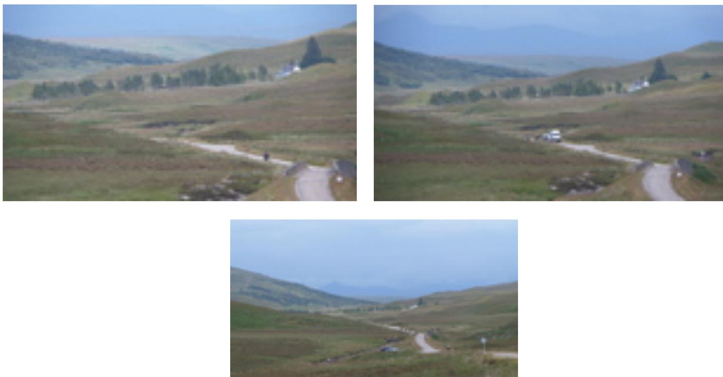
Sur ces photos, on remarque que la route, avant le panneau, s'élargit pour que les véhicules puissent se garer et laisser passer ceux qui viennent en face : ce sont les « passing place », présents alternativement tous les 50 ou 100 m. Totalement utilisés par les locaux.
