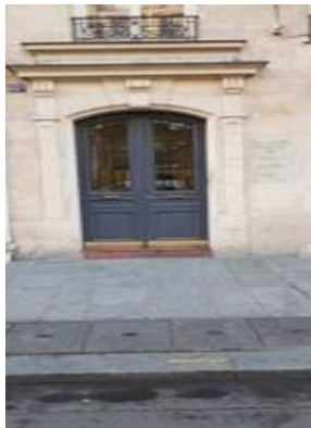
Building B entry: Entrée du bâtiment B
