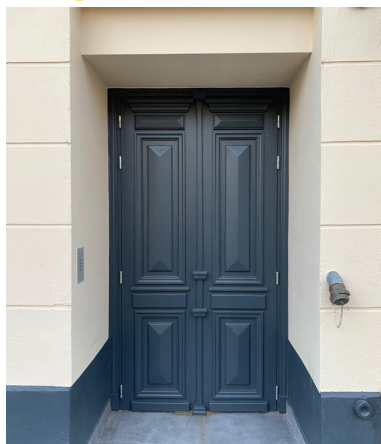
Front door/Porte d'entrée
