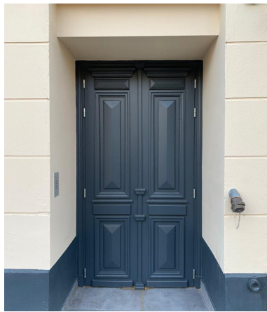
Front door/Porte d'entrée
