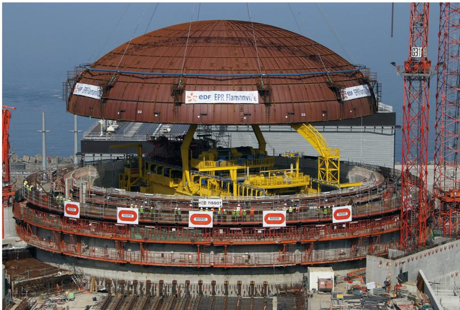
FIGURE 4 – Bâtiment réacteur de l'EPR de Flamanville en construction
