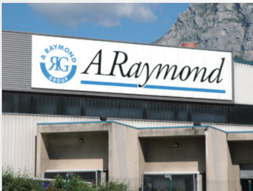
Panneau mural de 14 x 3 m en éléments verticaux sur lisses.
