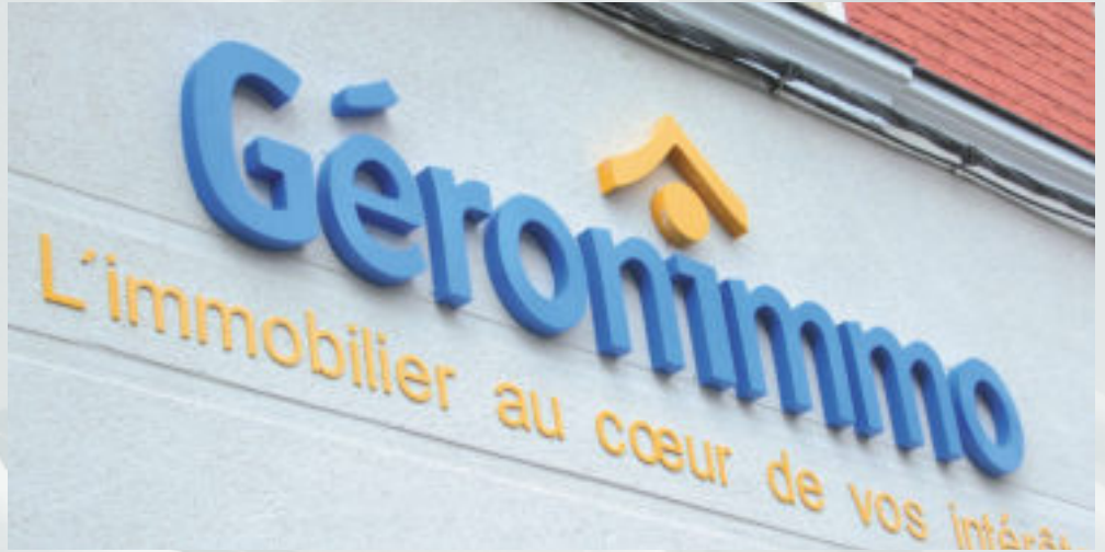
Lettres métalliques et logo en relief en TEZ et lettres à plat en tôle d'aluminium de 4 mm.
