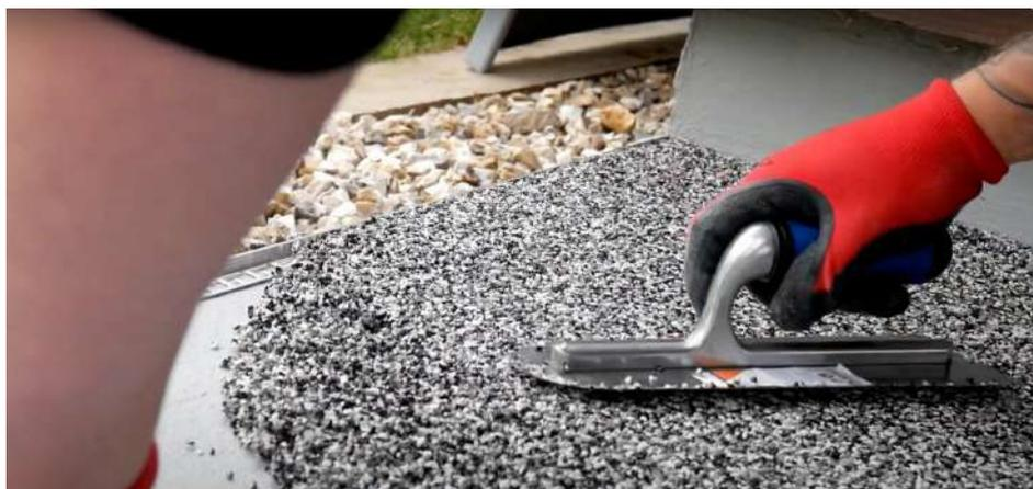
**5.6** Puis répétez ces étapes autant de fois que nécessaire, pour recouvrir la totalité de votre surface jusqu'aux baguettes de finition.
