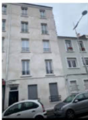
Building Entry / Entrée du bâtiment 260 rue Etienne Marcel. 93170 Bagnole
