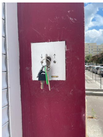
Turn the key to raise the electric curtain Tourner la clé pour lever le rideau électrique
