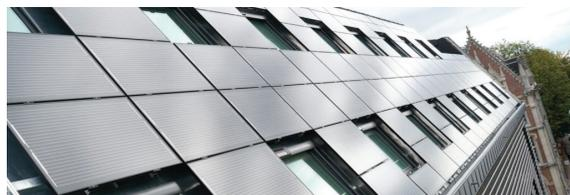
1200 m<sup>2</sup> de panneaux photovoltaïques permettent au Rizom de produire et d'auto-consommer son énergie au service des usagers et des équipements, dont des bornes de recharge pour véhicules électriques. ▼
