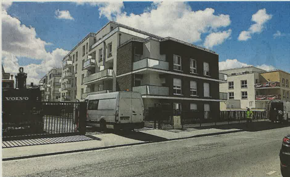
Vue d'ensemble des nouveaux bâtiments construits à côté de l'institut Lemonnier, rue d'Hérouville.
