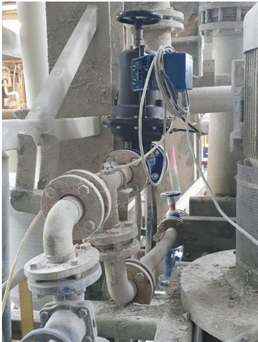
Ensuite, les mécaniciens ont effectué le remplacement d'une vanne et nous avons raccordé cette dernière. Nous l'avons ensuite testé depuis la salle de contrôle. Cette vanne utilise du 4-20mA en commande.
