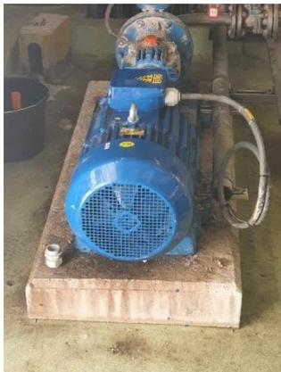
**De 9h30 à 15h15 :** J'ai changé de binôme et été mis sur l'arrêt de la division STPP. Nous avons décâblé 2 moteurs, les mécaniciens sont venus les changer, et nous avons raccorder les nouveaux moteurs. On m'a également expliqué que le sens de rotation du moteur a son importance avec la pompe qu'il entraine. Le sens de rotation du moteur est indiqué sur la pompe. Nous avons également (pas moi) retiré des fusibles en sous station (etc...)
