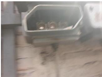
J'ai donc remplacé les 3 fusibles bouteilles. (20A)
