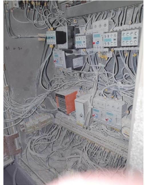
De 12h à 14h50 : nous avons resserré tous les contacts du coffret. (Bornes, contacteurs, temporisation, disjoncteurs, ...) afin d'éviter les éventuels arcs électriques avec le temps dû aux vibrations et aux desserrages des contacts.
