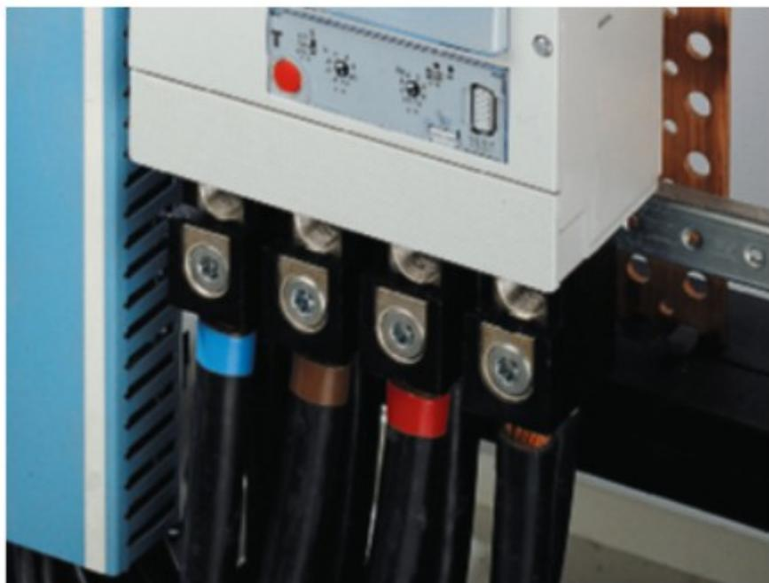
Raccordement de deux conducteurs aluminium de 185 mm<sup>2</sup> par pôle sur d'un DPX<sup>3</sup> 630 avec les bornes réf. 0 261 51
