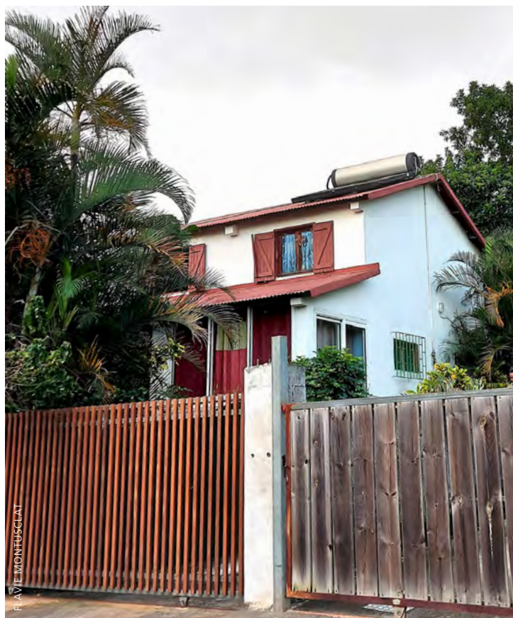
Capteur solaire thermique thermosiphon installé dans la commune de La Saline-les-Hauts, sur l'île de la Réunion.
