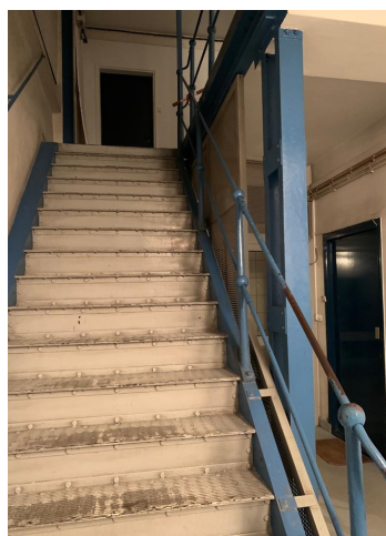
The apartment is in front of the stairs on the 2nd floor/ L'appartement se trouve en face des escaliers au 2ème étage.
