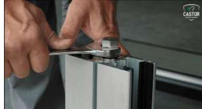
4. Respecter l'ordre d'assemblage des planches, vérifier leur centrage dans les poteaux (elles doivent recouvrir les joints à lèvres équipant les poteaux).
