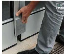
4. Tracer sur le sol le contour extérieur du poteau H.
