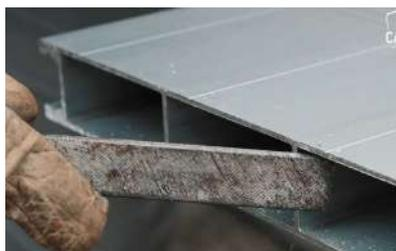
4. Mettre en place le joint intermédiaire, dans son logement en veillant au sens. Vous pouvez vous aider en appliquant un peu de liquide vaisselle au préalable, dans les rainures recevant le joint
