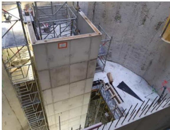
Jules Guesde Le Kremlin-Bicêtre Avancement GC Structures internes
