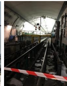
Travaux TN2 : Création LT en souterrain, condamnation arrière gare, ouverture trémie, démantèlement atelier
