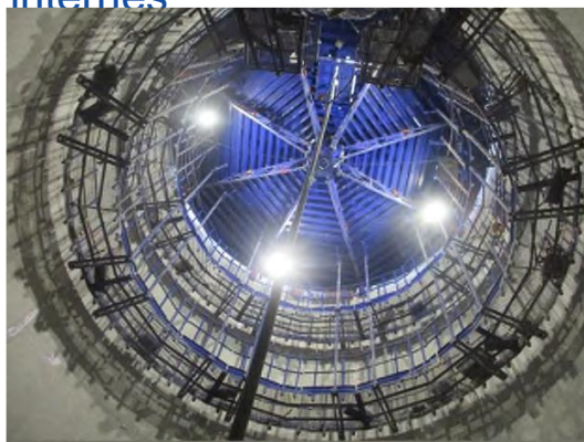
Marcel Sembat Le Kremlin-Bicêtre Conférence de la Ligne 14 Sud Avancement GC
