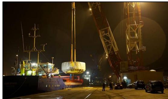
**Fig. 14. Manutention d'éléments de l'éolienne ALSTOM à destination du Carnet - Exemple de plateforme bord à quai aménagée**
