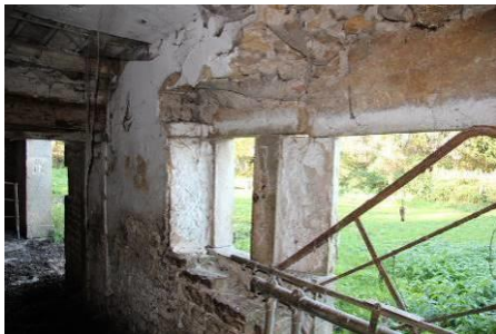
La poutre de 4 m qui soutenait la totalité du parement intérieur manquait. Elle est remplacée.
