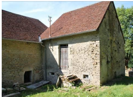
Pour ne pas déstabiliser les fondations des murs, la végétation est supprimée. L'escalier est incomplet.
