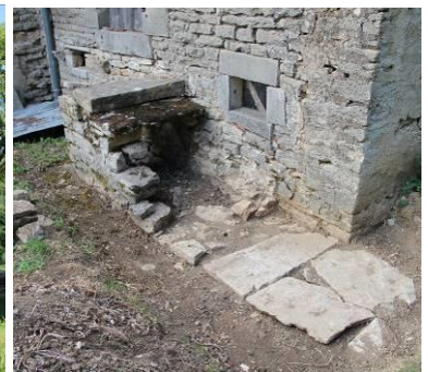
Pour ne pas déstabiliser les fondations des murs, la végétation est supprimée. L'escalier est incomplet.
