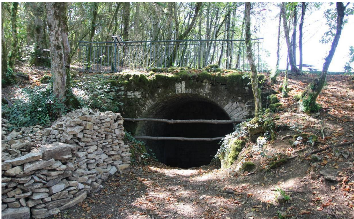
Sécurisation de la citerne avec pose d'un garde-corps.
