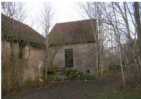
Pour ne pas déstabiliser les fondations des murs, la végétation est supprimée. L'escalier est incomplet.
