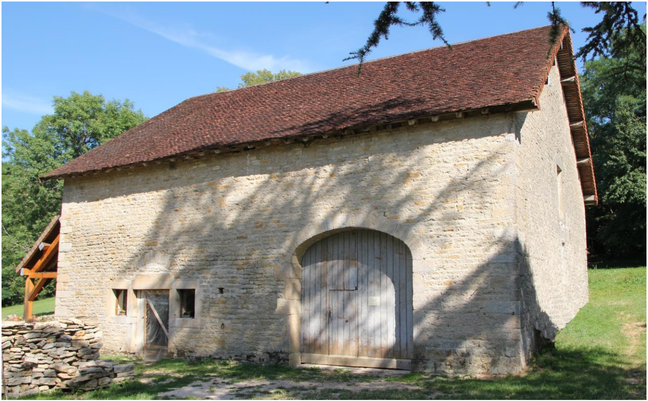
Une porte de grange est installée afin d'arrêter le vent qui s'engouffrait et soulevait les tuiles. L'entretien du toit permet de supprimer les fuites d'eau.
