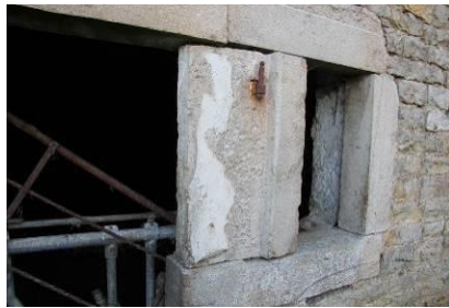
Les jambages et le linteau de la porte de l'écurie sont repositionnés. Tentative échouée de vol de pierres ?
