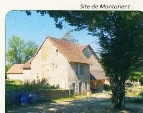
Site de Montorient
