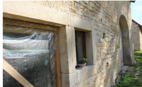
Les jambages et le linteau de la porte de l'écurie sont repositionnés. Tentative échouée de vol de pierres ?
