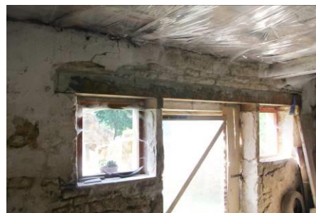
La poutre de 4 m qui soutenait la totalité du parement intérieur manquait. Elle est remplacée.
