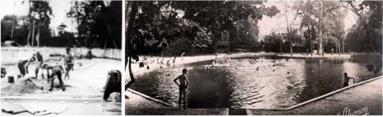
La piscine : de la construction ... à la réalisation, 1947, Fonds JC. Rouvière
