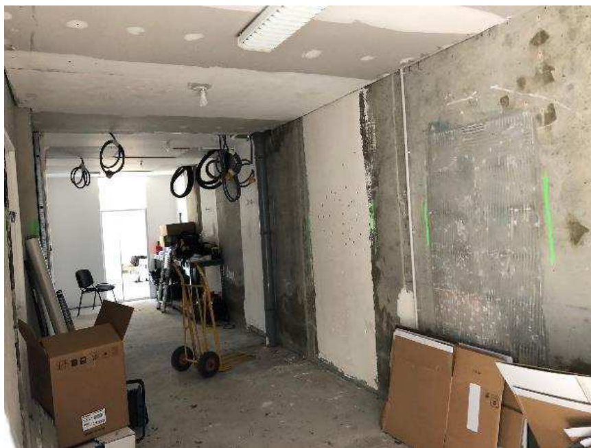
Figure 2 – Local vide à aménager en laboratoire solvants.
