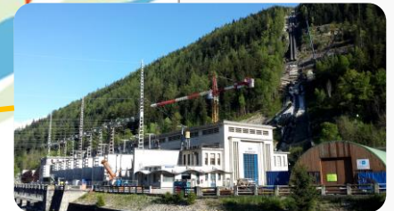
Centrale de Malgovert
