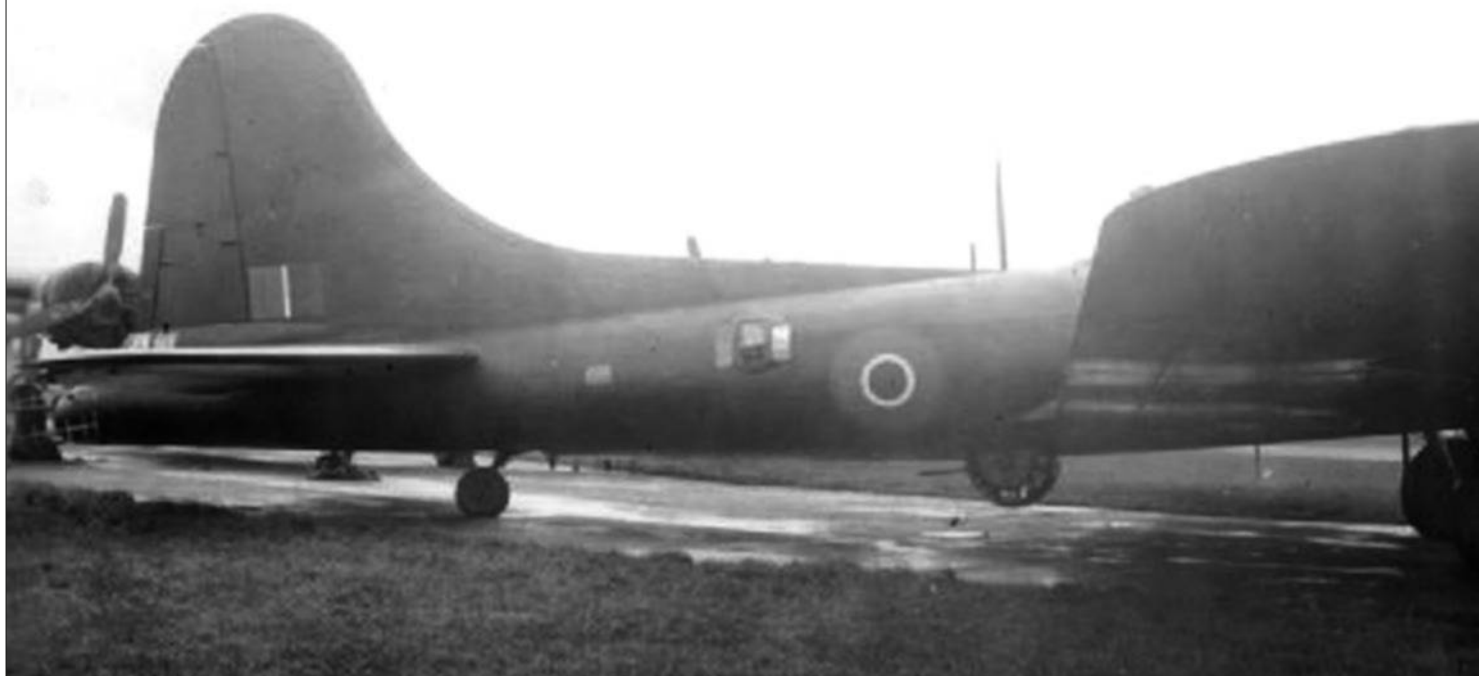
B-17 de brouillage de la Royal Air Force. Durant la Seconde Guerre mondiale, il appuyait les raids de bombardement alliés en brouillant les radars de la DCA allemande. (Royal Air Force)
