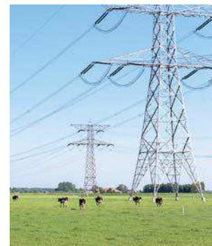
**Comme tout champ électromagnétique, l'intensité du champ ELF issu d'une ligne THT décroît très rapidement avec la distance.** À partir de 100 mètres, il est quasi nul pour une ligne 400 KV. En 225 KV, on ne le distingue plus dès 50 mètres.
