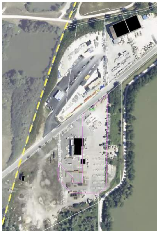
Figures 105 : La Zone d'Activités « le Grand Parcours » et l'aire de stockage de l'A36
