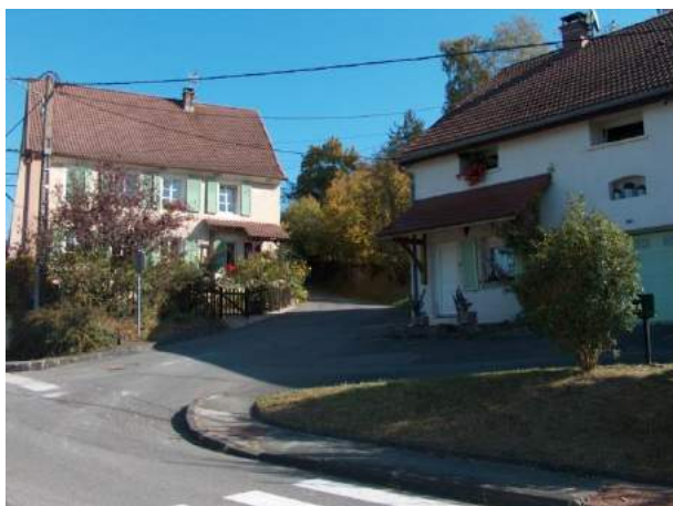
Figure 97 : Toiture en tuile plate et volets en bois
