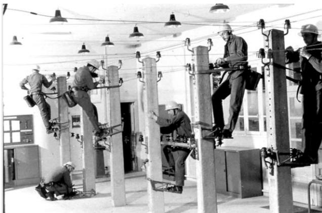
avec les grimpettes adéquates, manutention en toute sécurité d'échelles, simple, double ou triple, avec levage
