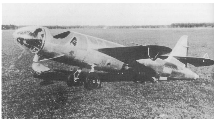
Le He 176 fût le premier avion propulsé par un moteur fusée à carburant liquide. Il n'effectua que quatre vols (été 38) qui ne convainquirent pas les responsables nazis qui le jugèrent trop dangereux.
