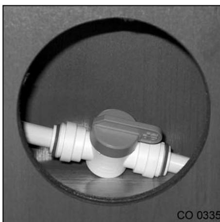
Photo 10-7 Valve d'arrêt (exemple dans un meuble)
