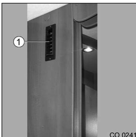
Photo 10-29 Sortie d'air froid (exemple)
