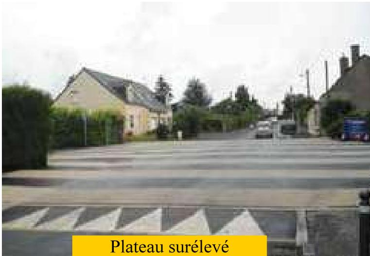
*Les plateaux surélevés doivent être adaptés au passage des convois agricoles : la pente des rampants ne doit pas excéder 5 % .*
