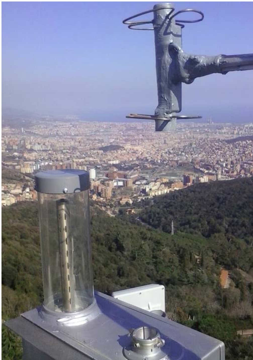
ATV boîte de répéteur dans la tour sur Barcelona . L'antenne de sortie 10GHz e l'antenne d'entre de 23cm
