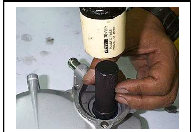
Outil de pose de roulement
