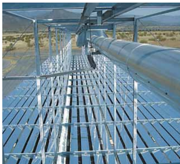
Figure B.7 - Installation à concentrateurs de Fresnel linéaires
