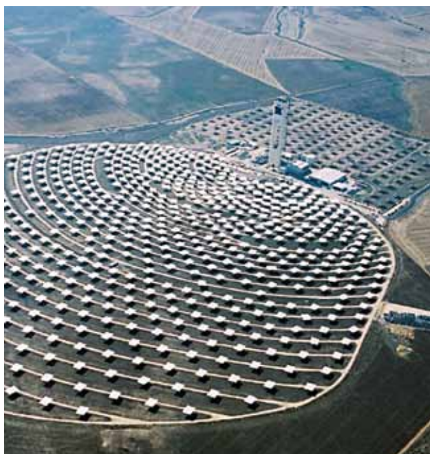
Figure B.8 – Installation à récepteur central
