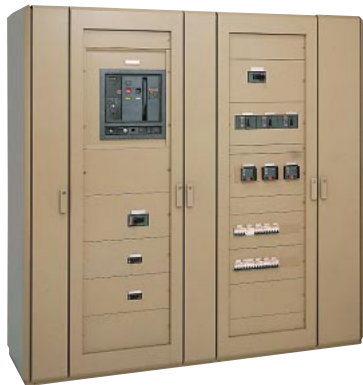
Isolation au moyen d'une enveloppe.
